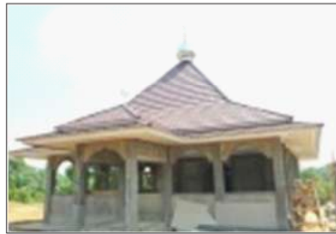
Masjid Nurul Huda (baru) (Tahap Penyelesaian Pembangunan 90% Bantuan PT.Pertamina (Persero) Jakarta
