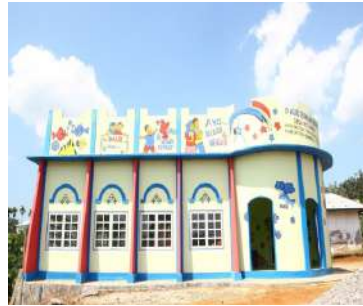
Bangunan PAUD baru (Bantuan PT.Pertamina Region Sumbagsel Tahun 2014)
