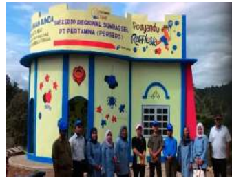
Bangunan Posyandu (baru) (Bantuan PT.Pertamina Region Sumbagsel Tahun 2014)
