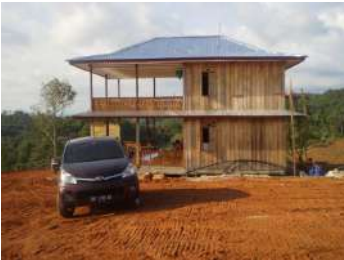
Tampak samping kiri sebelum finishing
