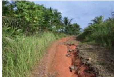
Gambar 3 C Jalan poros desa di dekat lokasi KEM
