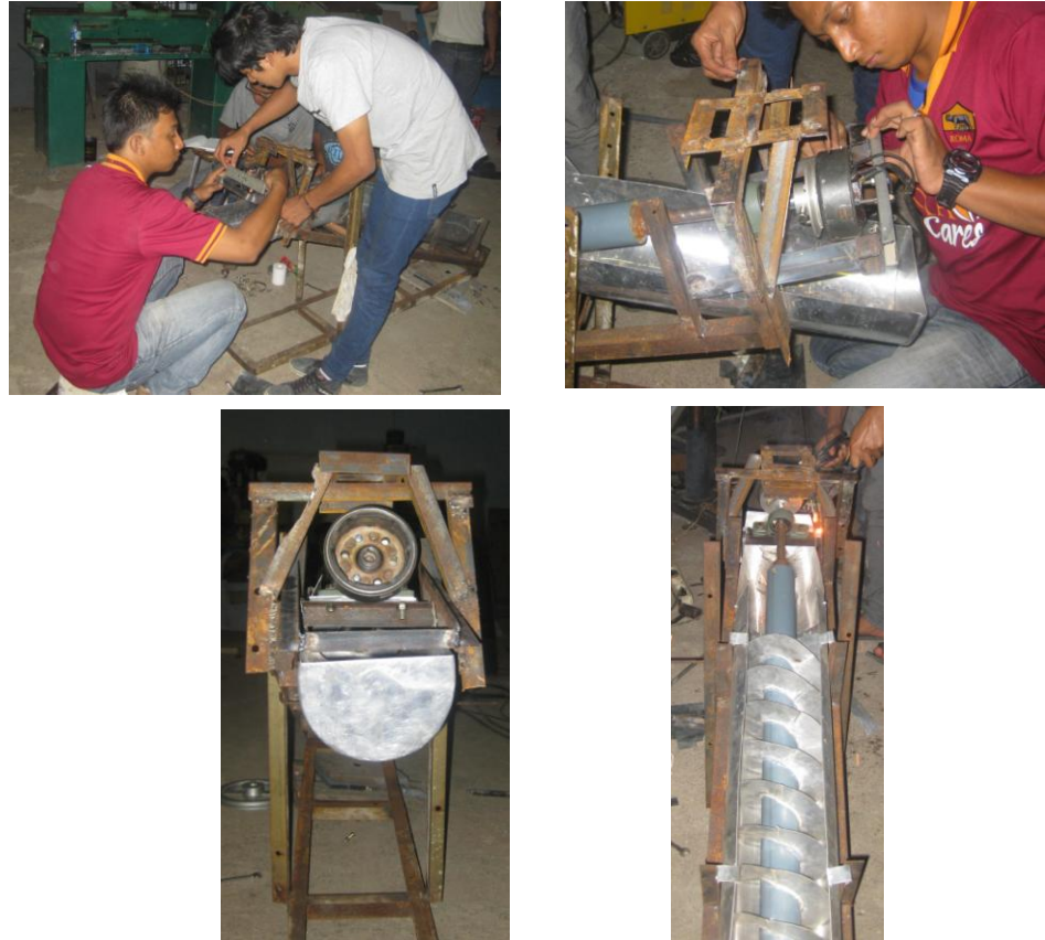
Gambar 5.7 Pemasangan Magnet Motor dan Lilitan pada Screw turbin
