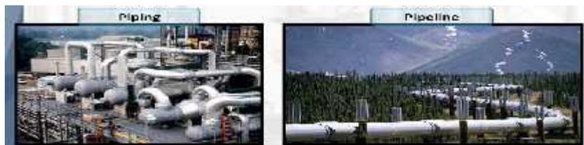
Gambar 2.1 Perbedaan *Piping* dan *Pipeline* (Fenn, 2012)
