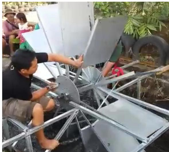
Gambar 2. Instalasi undershot waterwheel di desa Baturoto
