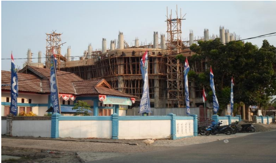
Gambar 9. Pembangunan Shelter Bencana Tsunami diKelurahan Teluk Sepang Kecamatan Kampung Melayu Kota Bengkulu
