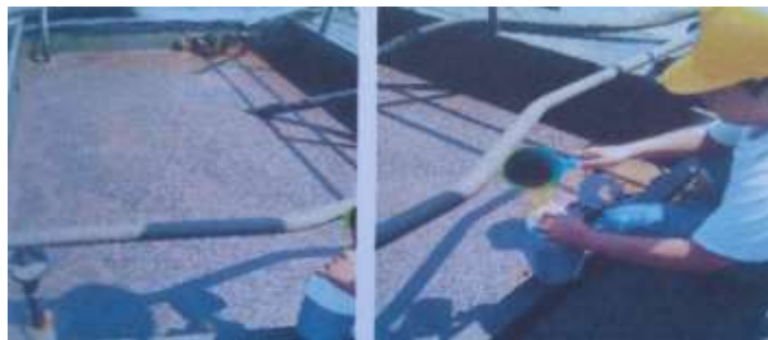
Gambar 1. Proses pengambilan minyak sawit dari bak Fat Pit
