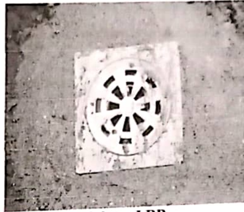
Gambar 8. Pemasangan tutup paralon dan lubang LRB
