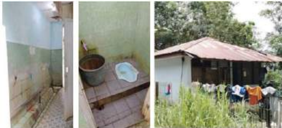
Gambar I. 2 Fasilitas masjid Universitas Bengkulu
