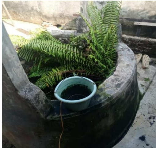
Gambar 15. Kondisi Sumur Gali pada Sampel 5
