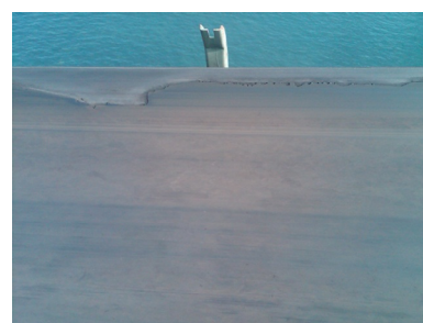
Gambar 21. Belt conveyor pada PT. Pelindo II
