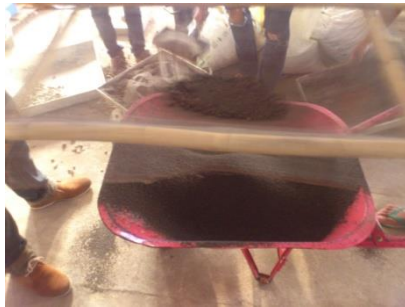
1. Pasir disaring dengan ayakan 2 mm
