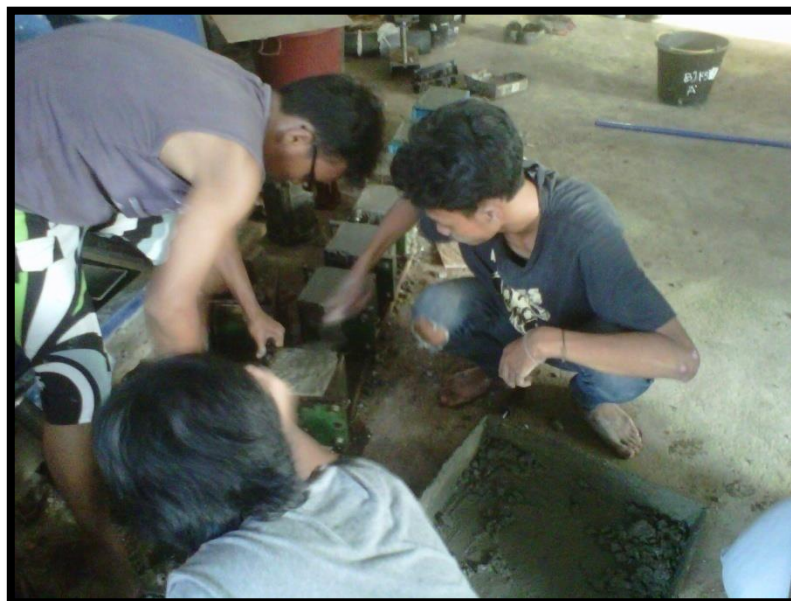
Gambar 4.11 Proses Pencetakan Beton
