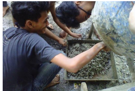
6. Hasil pencampuran adukkan di dalam molen
