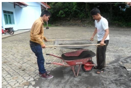
Pasir disaring dengan ayakan 2 mm
